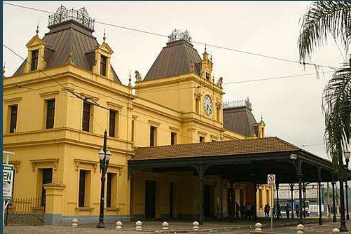
1 - Estação do Valongo - Santos
